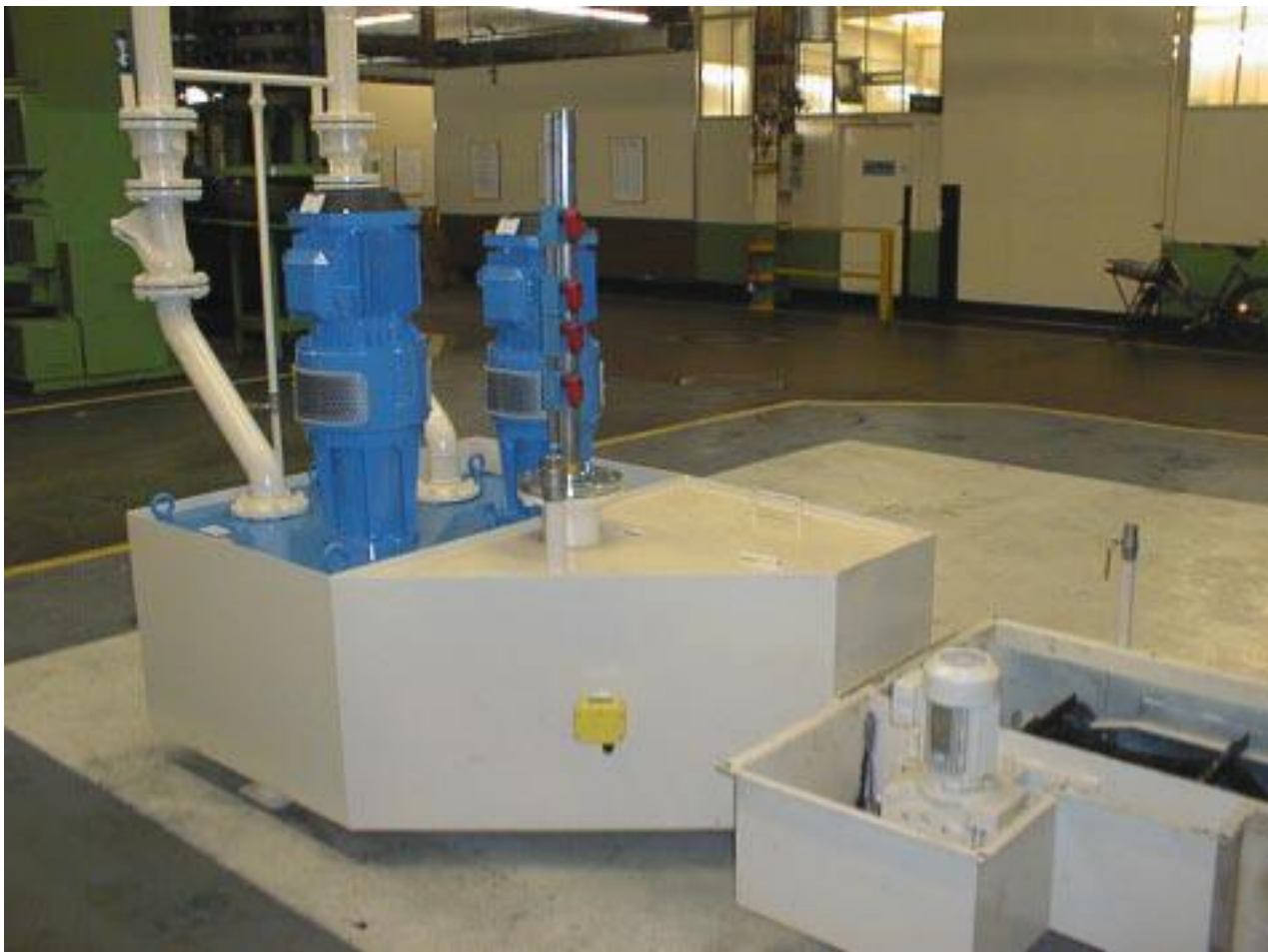
Anwendungsbeispiel von Eggerpumpen in einer Rückpumpstation für Transferstrassen.
