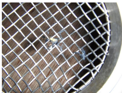
Vervuiling in aanzuig filter.
