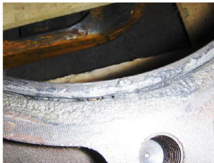
Zuigstuk, afdichtingsvlak aangetast
