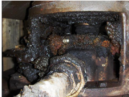
Buitenzijde seal kamer, vervuild
