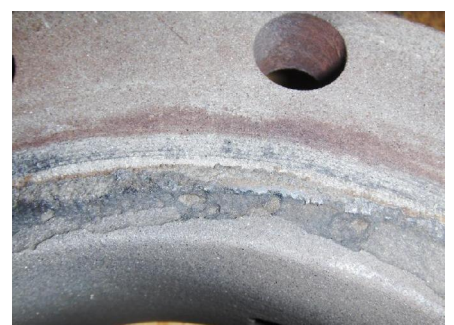
Zuigstuk, afdichtingsvlak aangestast
