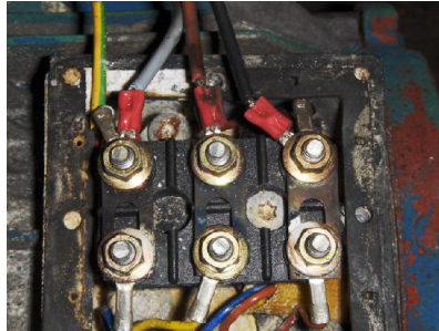
Aansluit kast E-motor, verbrand door sluiting.
