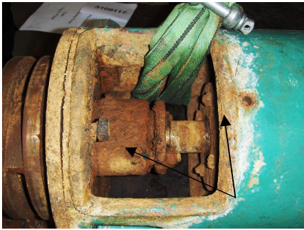
Pomp aangetast door corrosie
